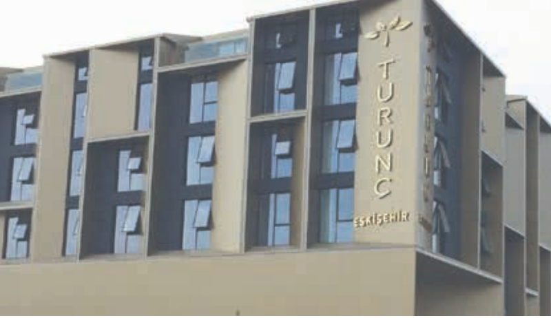
Turunç Otel Eskişehir
