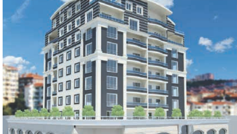
Konat İnşaat Bursa
